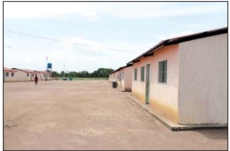
Las casas se construyen en la comunidad Tres Lagunas.
