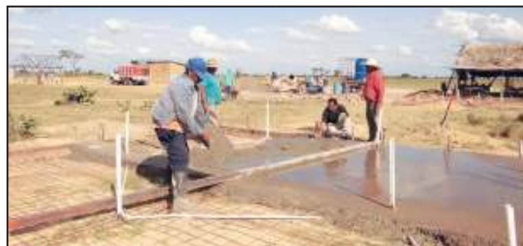
El consejo comunal participa en la construcción de esta obra.
