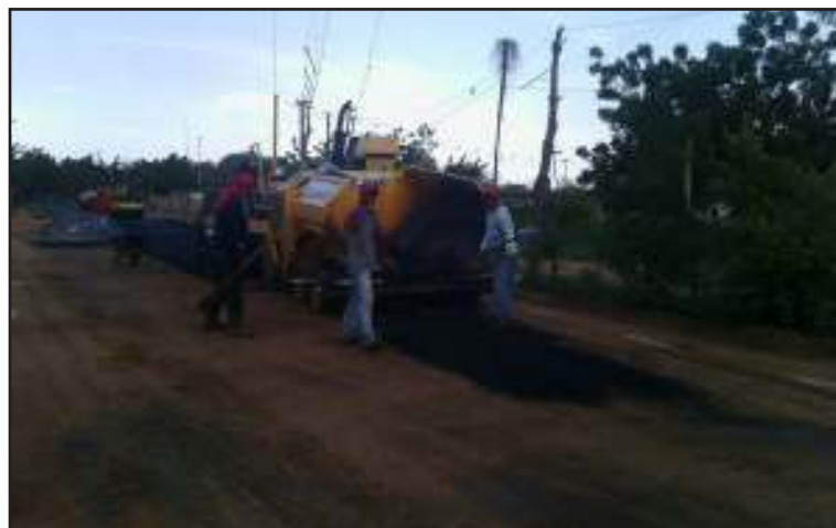
Estos trabajos permitirán el acceso del transporte público al sector.
