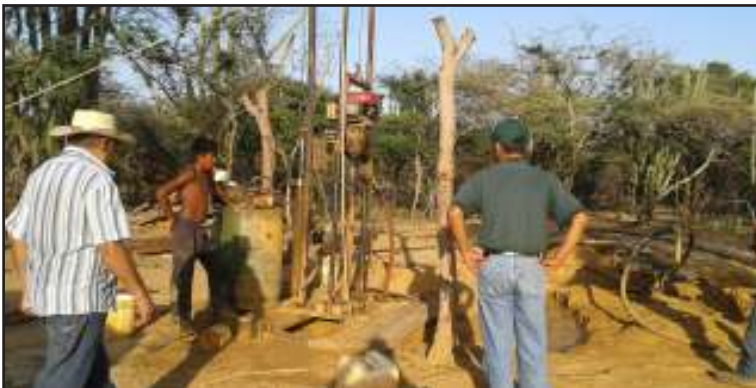
Los espacios están siendo acondicionados con apoyo del Minpppi.
