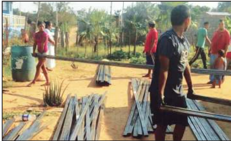
Esta obra presenta un 60 por ciento de avance.
