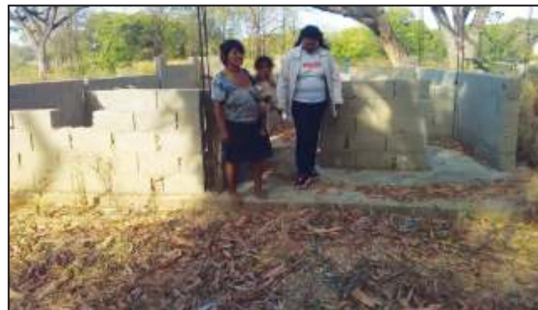
La Viceministra Rosa Delgado inspeccionó el inicio de la obra.
