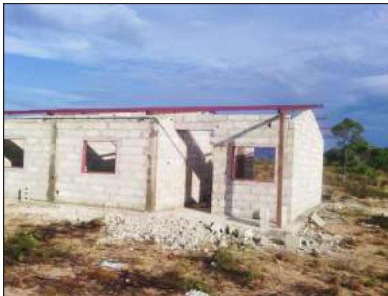
Esta obra presenta 55 por ciento de avance.
