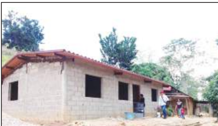
Las viviendas cuentan con un 75 por ciento de avance.
