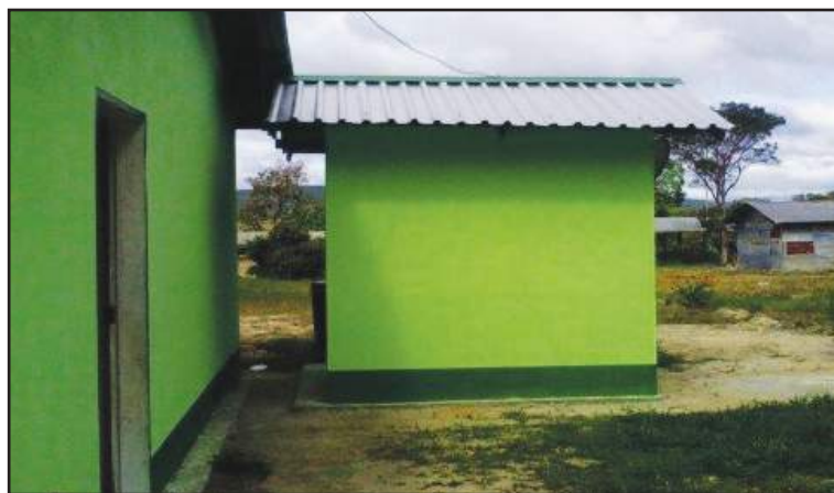
El Minpppi construye y rehabilita viviendas a favor del vivir bien.
